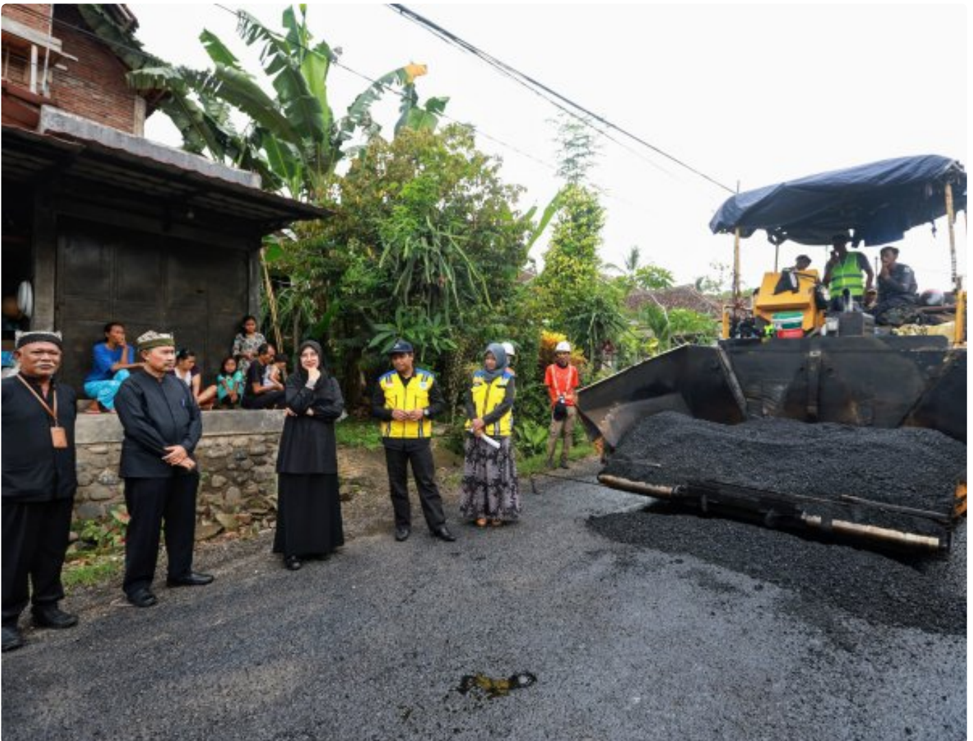
Bupati Banyuwangi Ipuk Fiestiandani meninjau progres pengerjaan pembangunan ruas jalan Rogojampi-Songgon
